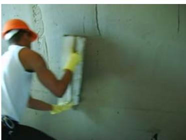
Os revestimentos de argamassa são utilizados para dar acabamento e revestir tetos, paredes externas e internas, impermeabilizando e proporcionando melhor conforto termo-acústico ao ambiente.
