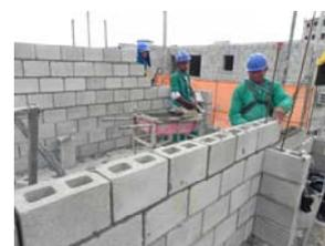
Por outro lado o bloco de concreto também pode ser empregado estruturalmente, compondo a alvenaria estrutural com blocos de concreto, um sistema construtivo no qual as paredes compõem a estrutura da edificação, além de desempenharem a função convencional de elemento de vedação (dividir ambientes).
