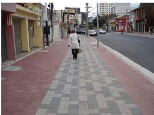
A pavimentação intertravada com peças de concreto é uma excelente alternativa para as áreas urbanas das cidades – principalmente em calçadas –, tanto do ponto de vista técnico quanto econômico.
